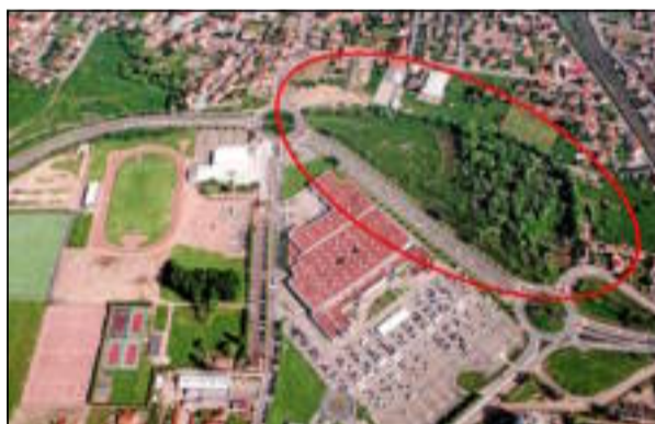
● Le Retail park serait situé sur la zone des portes de Riorges 2.
